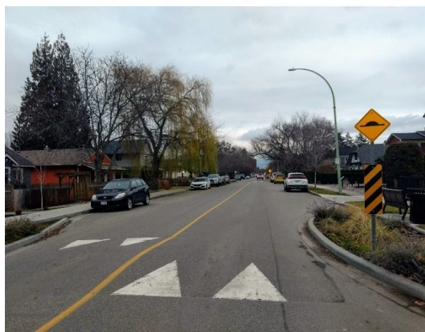
Dispositifs de modération de la circulation (dos d'âne et avancées de trottoir sur les bordures de rue (Kelowna, Colombie-Britannique)
