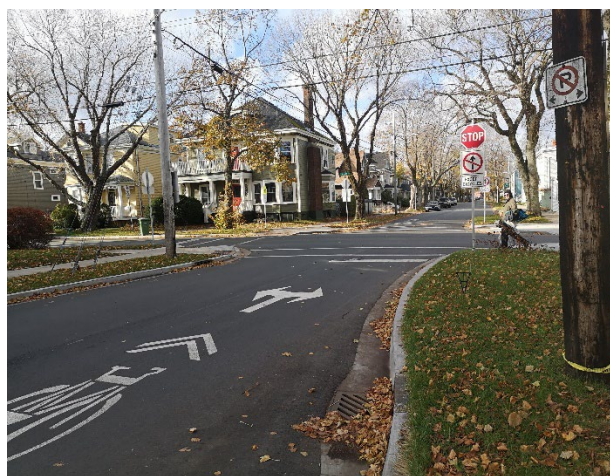
Avancée de trottoir sans restriction pour la circulation de transit (Halifax, Nouvelle-Écosse)
