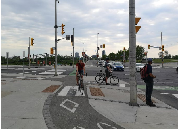
Intersection protégée (Ottawa, Ontario)
