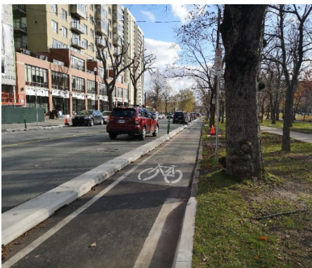
Voie cyclable protégée sur route avec bordure de béton (Halifax, Nouvelle-Écosse)
