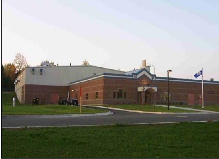
Figure 3 : Station de traitement des eaux de Moncton
