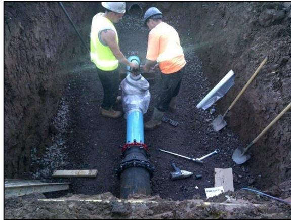
Figure 5 : Installation d'une vanne sur une conduite d'eau principale
