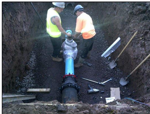
Figure 5 : Installation d'une vanne sur une conduite d'eau principale
